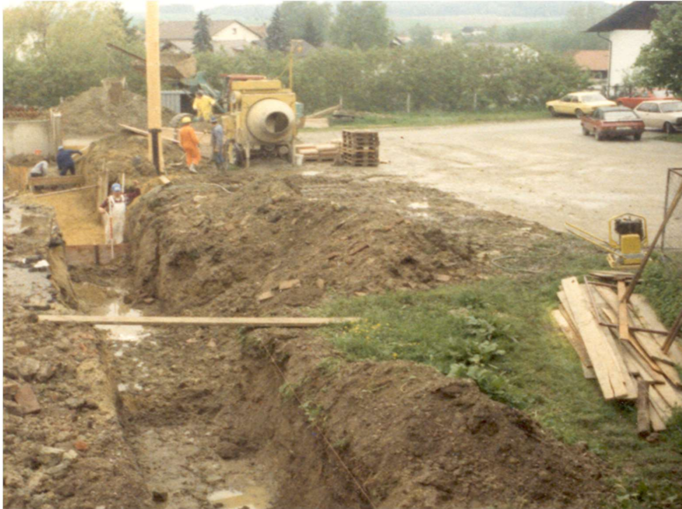
Baubeginn Halle beim Freilinger im Jahr 1986
